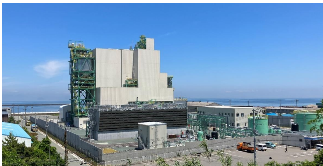
（大洲バイオマス発電所 全景）
